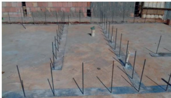
Figura 8 – Fixação dos arranques (Fonte: SALGADO, 2019)
