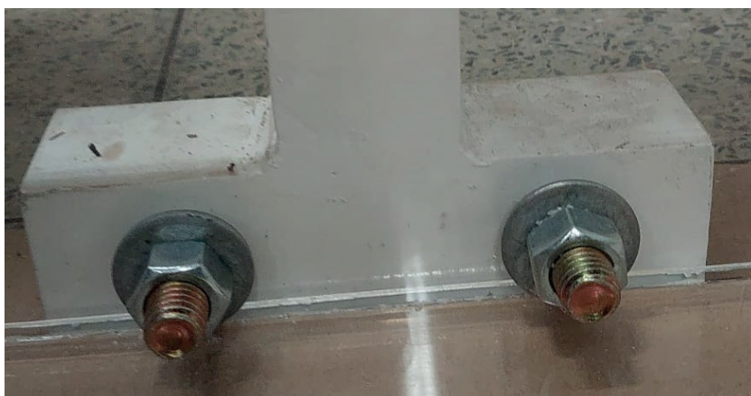
Figura 6 - Fixação da estrutura metálica
