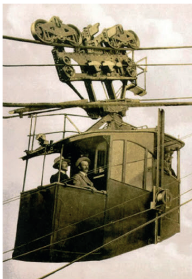
Figura 7. Sistema de transporte por cable aéreo construido por la compañía Caretti y Tanfani -Italia. Fuente: https://aerosilla.tripod.com/medios_de_elevacion.htm
