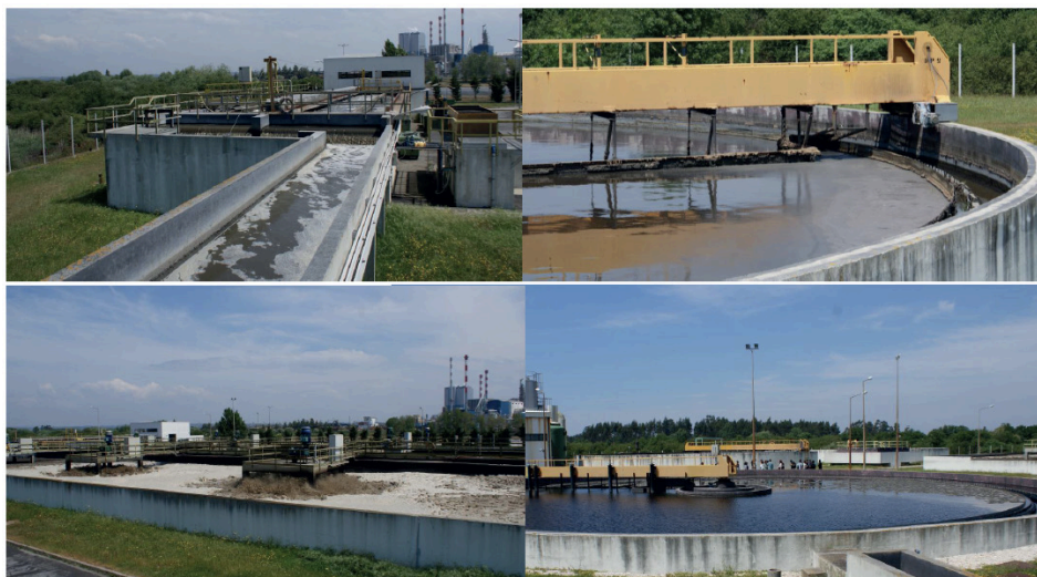
Figura 18. Estação de Tratamento de Águas Residuais (ETAR) de CACIA (Aveiro). Os processos de tratamento numa ETAR organizam-se em fileiras que depuram a fase líquida das águas residuais, recuperam uma grande parte da fase sólida (lamas convertidas em adubos e corretores orgânicos) e aproveitam o biogás para produção de energia. O tratamento de águas residuais nesta ETAR inclui três etapas, nomeadamente, o pré-tratamento, o tratamento primário e o tratamento secundário. As águas tratadas são posteriormente descarregadas no mar. Fotos da esquerda para a direita (cima): (1) pré-tratamento onde são removidos os resíduos de maior dimensão por gradagem, e onde ocorre o desarenamento e o desengorduramento; (2) decantação primária. Fotos da esquerda para a direita (baixo): (3) tratamento biológico; (4) decantação secundária.
