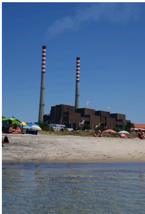
Figura 8. Por curiosidade refere-se o caso da Central Termo-Eléctrica de Sines (Portugal), encerrada em 2021, em que o arrefecimento dos condensadores era feito em circuito aberto, por circulação de água do mar captada diretamente do oceano. Esta Central libertava para o mar água com uma temperatura superior (cerca de 8°C) à do meio receptor. Muitos turistas deslocavam-se propositadamente à praia de São Torpes (localizada perto dos canais de rejeição da Central) para conseguirem banhar-se numa água mais quente.
