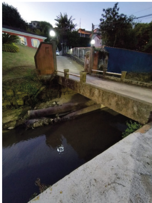
Figura 2: Pontes que diminuem a seção do rio na Av. Cel. Veiga
