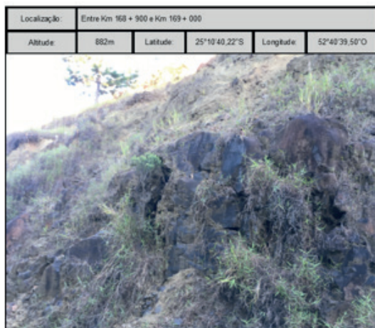
Figura 10 - Encosta com material de 2º e 3º categoria
