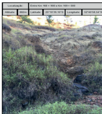
Figura 11 - Encosta com material de 2º e 3º categoria
