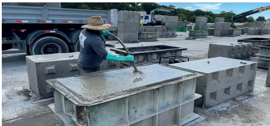
Figura 7 – Vibração do concreto lançado nas formas
