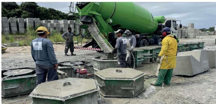
Figura 4 – Fabricação dos anéis hexagonais
