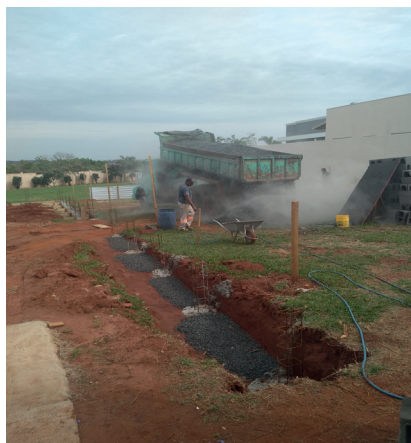
Figura 02: Obra residencial – Condomínio Fechado Uberaba MG
