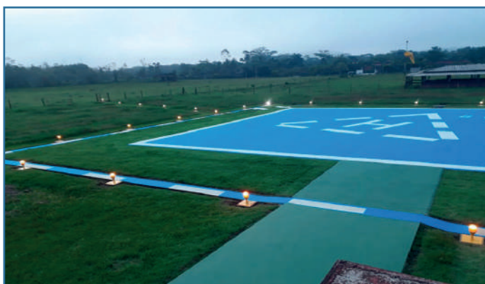
Figura 3 – Heliponto ao nível do solo em estrutura concreto/grama. Fonte: Flight internet
