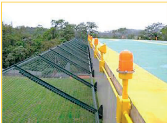
Figura 15 – SI da FATO composto por luminárias perimetrais da FATO e holofote para iluminação da TLOF. Foto: internet
