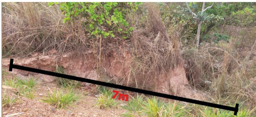
Figura 9 – Imagem da erosão do aterro, indicando o seu comprimento.
