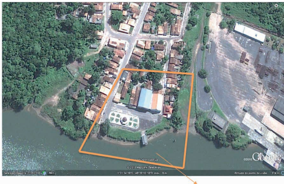
FIGURA 4: Vista aérea da parte central da Vila de São Francisco, (antiga Sede municipal de Barcarena) onde se localizava a missão jesuítica Gibiríe.
