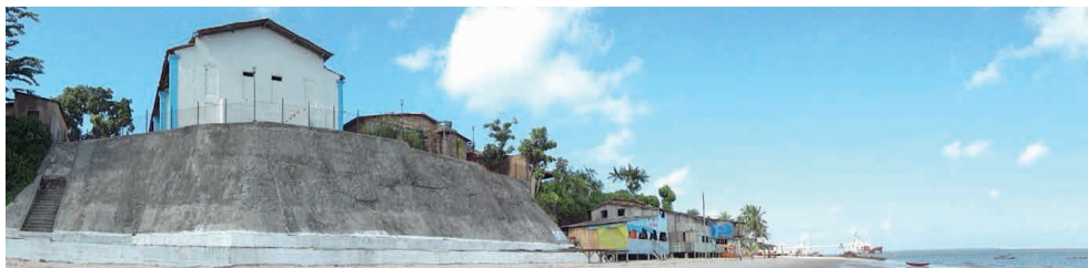
FIGURA 2: Imagem atual da Igreja de São João Batista de costas à baía do Marajó, em Vila do Conde no município de Barcarena – Pará, 2011.
