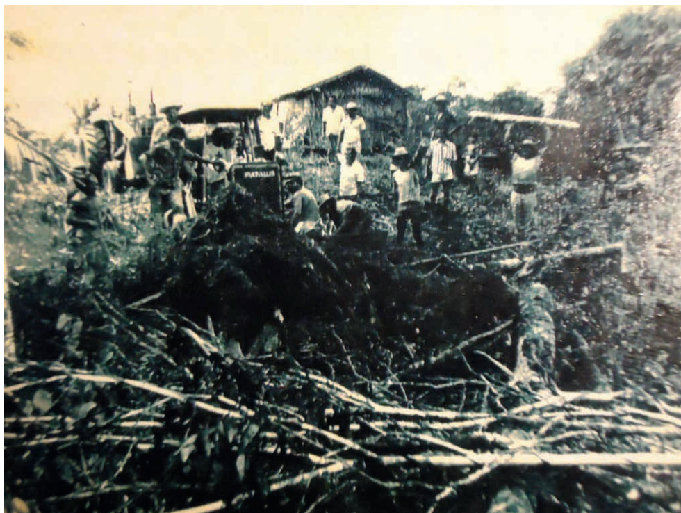
FIGURA 12: Imagem do início da construção de umas das ruas de Barcarena-Sede.
