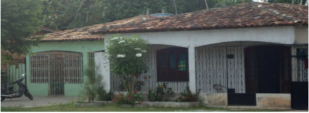
FIGURA 35: Imagem da similaridade das fachadas de duas casas em Barcarena Sede.
