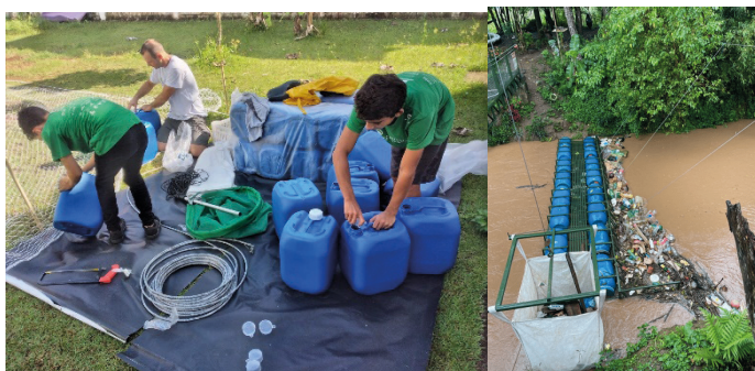
FIGURA 1 – PREPARAÇÃO DE ECOBARREIRA
