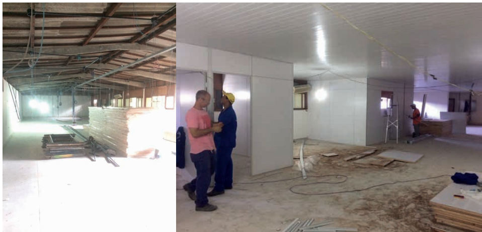
Figura 38- Reforma, ampliação e aquisição de equipamentos via TED 112/13.
