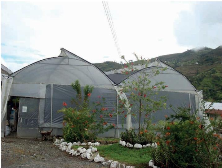
Figura 52. Estructura de invernadero para orquídeas con techo de plástico.
