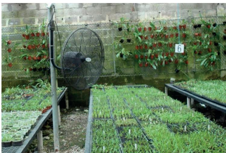
Figura 66. Sistema de ventilador en Invernadero de orquídeas. Cortesía: Ecuagenera, Ecuador.
