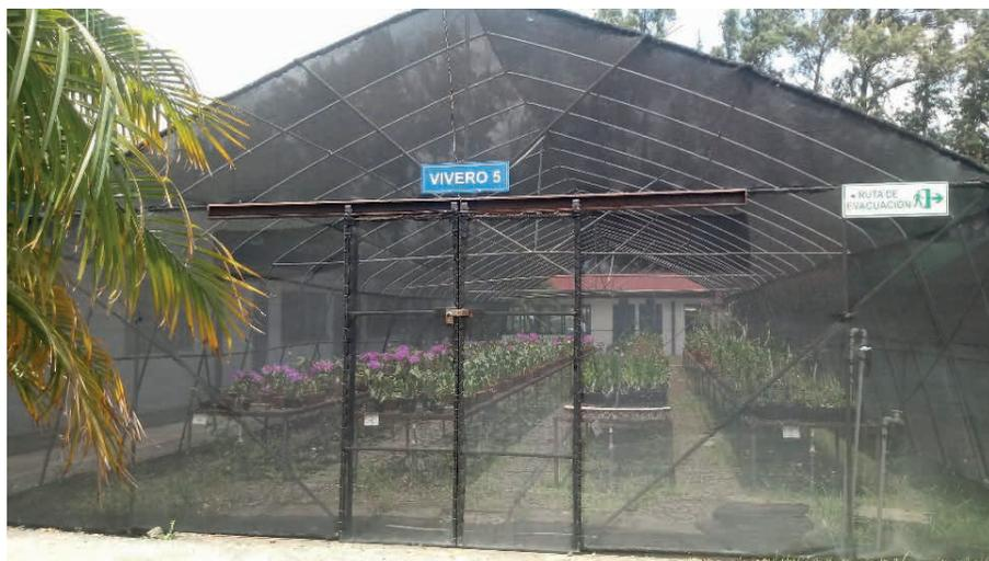
Figura 59. Invernadero tipo túnel.
