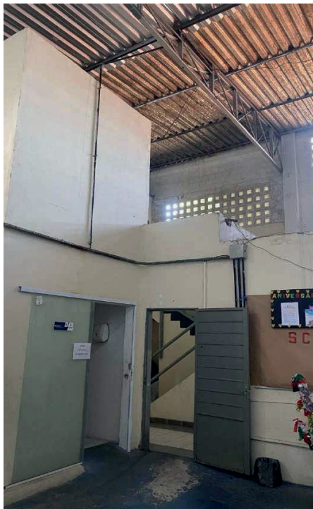
Figura 13 – Estrutura interna do CRAS Gilson Prado Barreto
