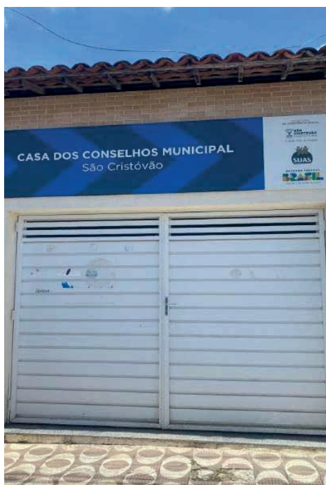
Figura 6 – Fachada da Casa dos Conselhos Municipal
