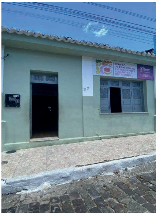
Figura 15 – Fachada do Centro de Referência em Segurança Alimentar e Nutricional
