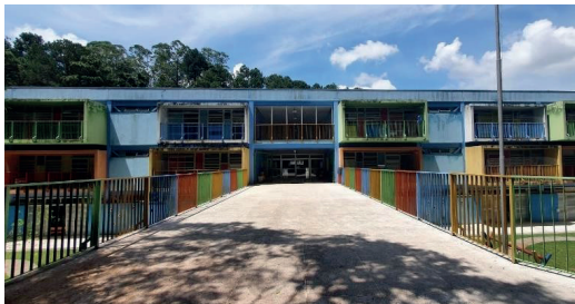
Figura 2: Fachada da EMEB Regina Rocco Casa I
