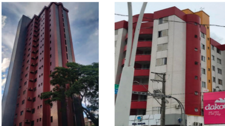
Figura 31 - Vegetação próxima às fachadas da direção sul na edificação e Fiação da rede elétrica próxima aos planos de fachadas da direção norte.
