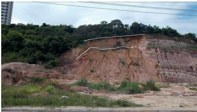
Figura 21: Mistura de deslizamento rotacional e translacional
