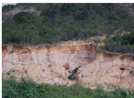
Figura 17: Deslizamento de terra localizado
