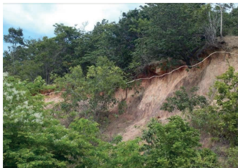
Figura 15: Processo de queda ou erosão localizada
