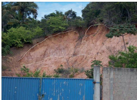
Figura 14: Mistura de deslizamento rotacional com queda
