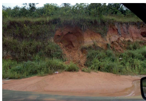
Figura 16: Erosão do tipo “ pipping ”
