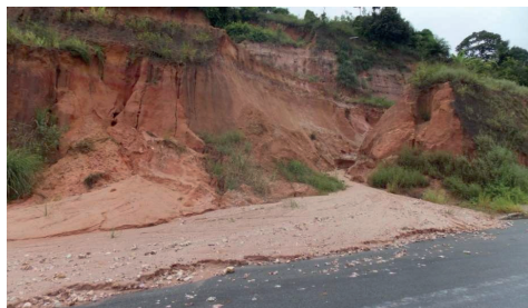
Figura 27: Pista parcialmente invadida por deslizamento
