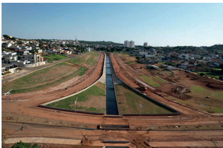
Figura- Canalização do Córrego Pirapitinga: 92% do projeto executado
