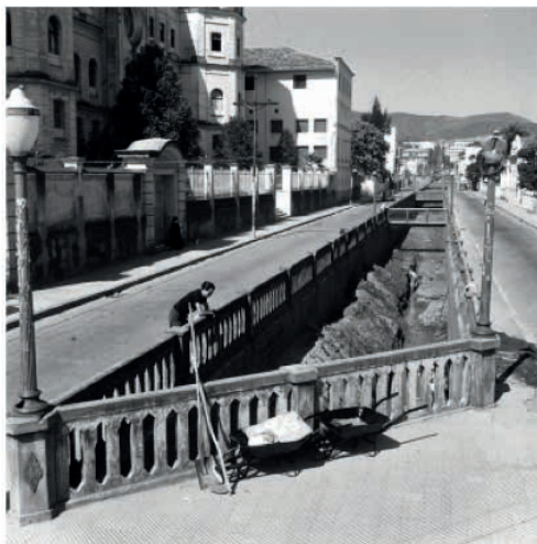
Figura 2: Canalização do córrego do Acaba Mundo. Rua Professor Moraes, 1964- 1965. APCBH, Fundo Assessoria de Comunicação.
