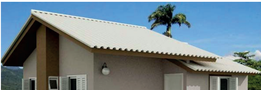
Figura 15 – Telha de Fibrocimento
