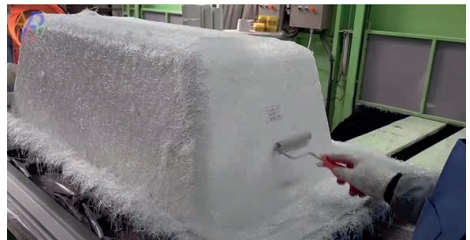
Adhesión del PRFV en toda la superficie mediante rodillos
