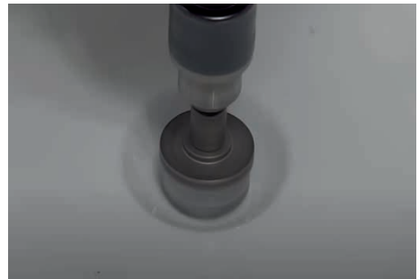
Perforaciones con broca sierra para los desagües
