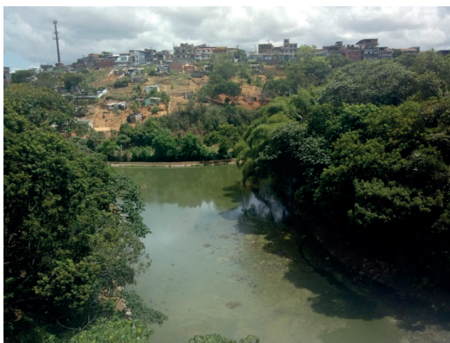
Figura 04. Fotografia de lagoa de despejo de efluentes domésticos pertencentes à Empresa Baiana de Saneamento. Ao fundo encostas com ocupação por moradias e solo desnudo. Fonte: Trabalho de campo realizado em fevereiro de 2019.
