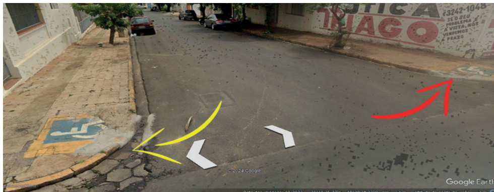
Figura 6. Imagem do trecho, notamos que nela há vários defeitos, desde a falta de um revestimento adequado até o tipo de material utilizado
