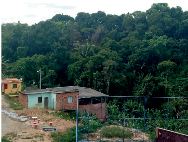
Figura 03. Fotografia que demonstra o avanço das construções sobre as áreas de proteção ambiental. Resultando no desflorestamento da mata ombrófila densa. Fonte: Trabalho de campo realizado em fevereiro de 2019.
