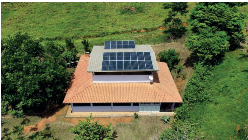
Figuras 93 e 94 – Microusina residencial de energia fotovoltaica
