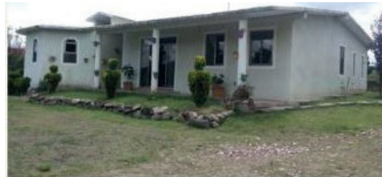
Imagen 5. Casa habitación de concreto producto de la gentrificación.
