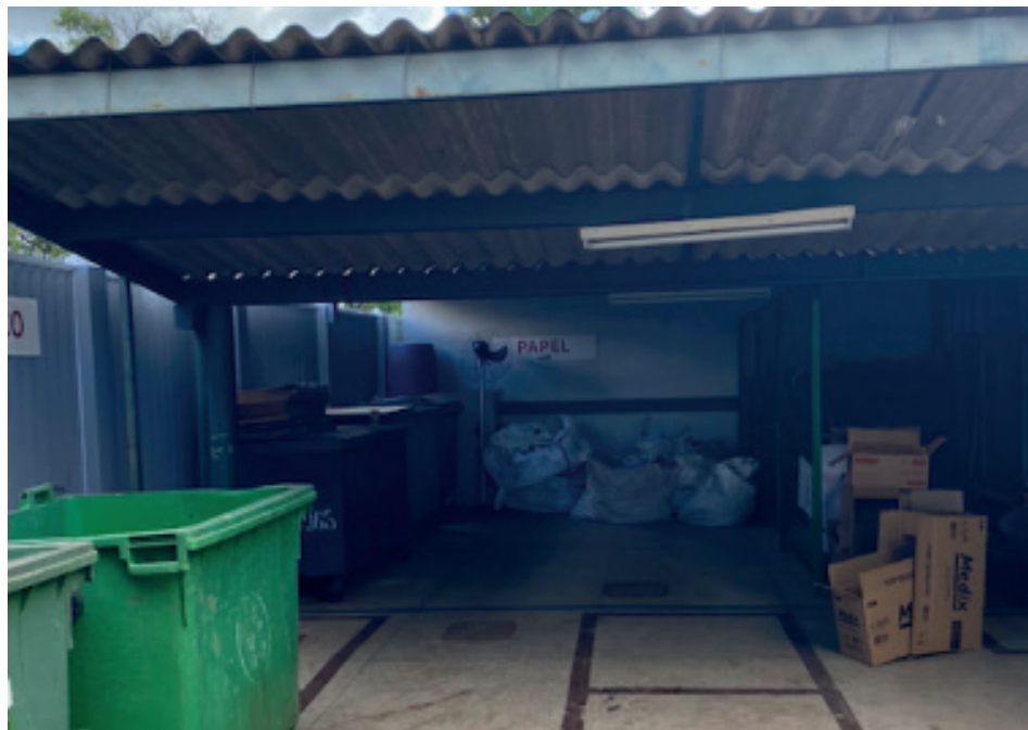
Figura 1 - Abrigo de resíduos do CEUB.
