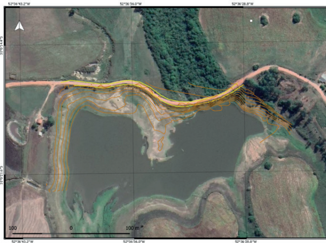
Figura 1 - Localização e situação da Barragem B2 do Assentamento Renascer
