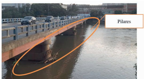
Figura 11 – Ponte Flávio de Miranda Gonçalves
