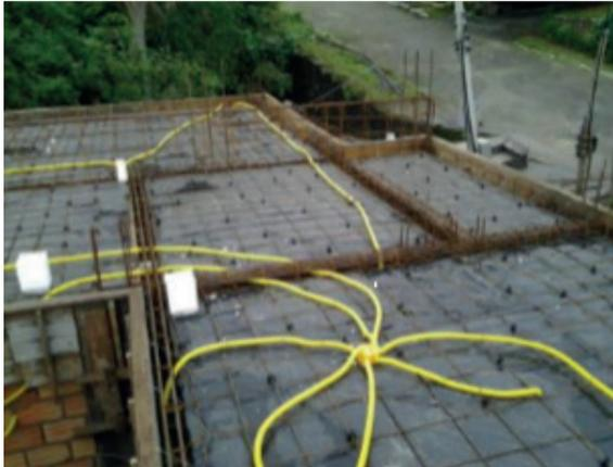
Figura 32 - Laje preparada com a passagens de conduítes e caixas de iluminação
