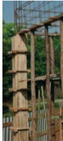
Figura 20 - Fôrma de madeira para pilares
