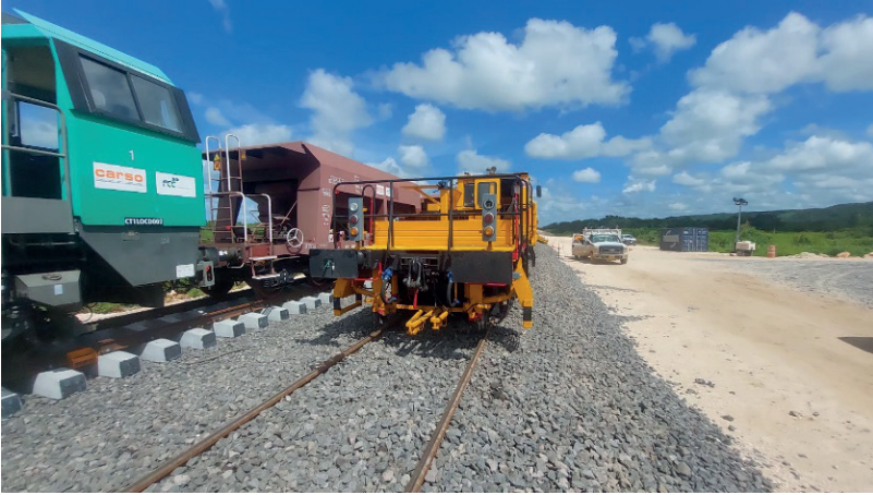
Figura N° 4: avance de obra del Tren Maya.
