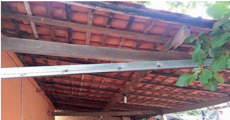
FIGURA 1. Vista general de la cubierta de madera Pau D'arco
