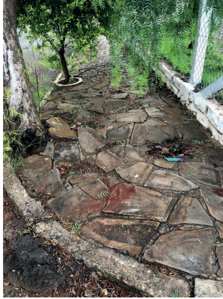
Figura 14: Fonte: Oliveira, I. Calçada.
