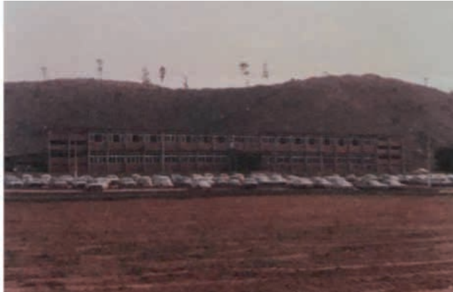
Imagem 4 – A nova sede da FADIC, no Bairro Martinelli
