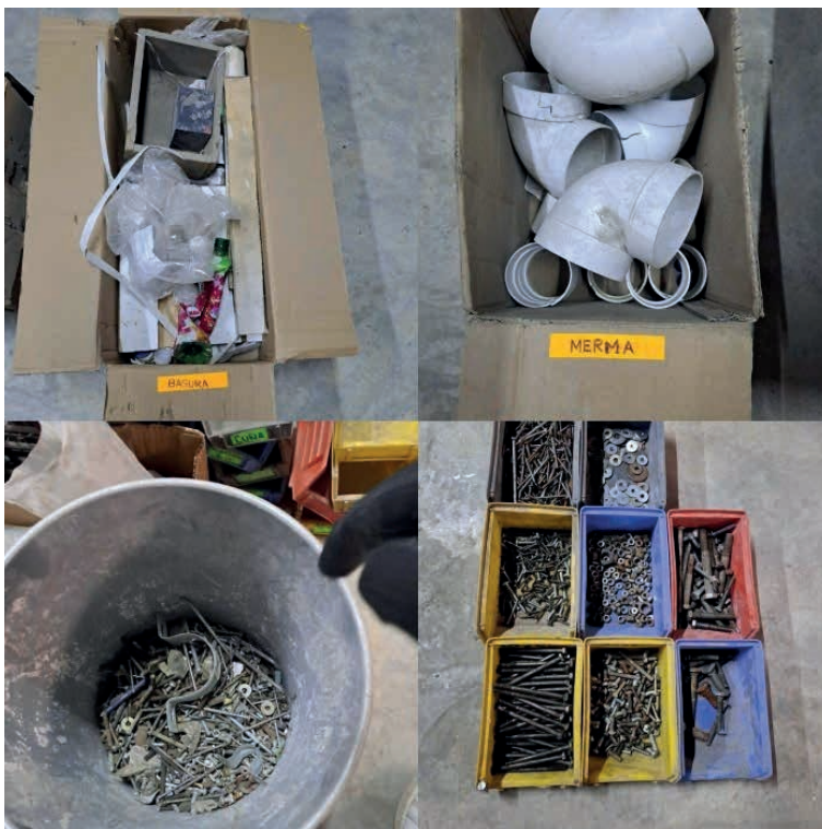
Figura 2 - Identificación, separación y depuración de materiales.
