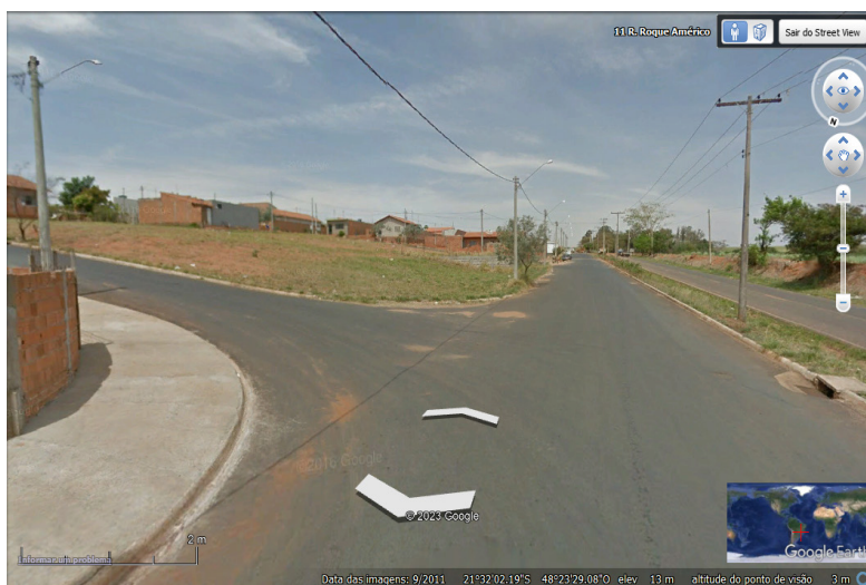
Figura 13. Vista da região próxima bairro em construção do município de Dobrada-SP.
