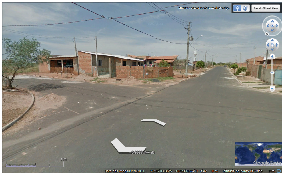
Figura 14. Vista da região próxima bairro em construção do município de Dobrada-SP.
