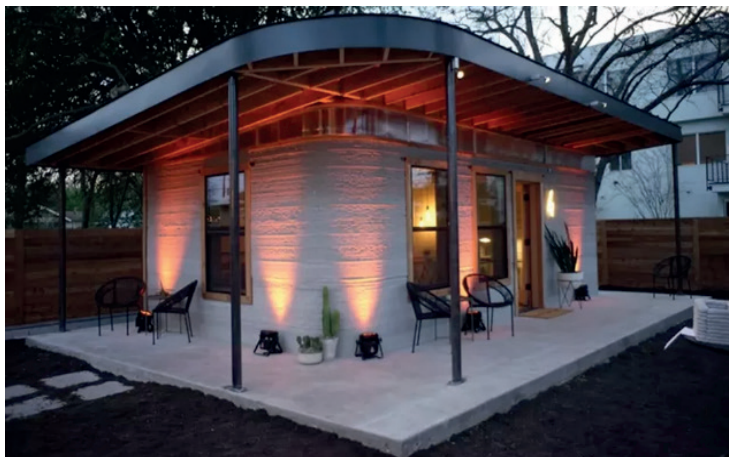
Foto 2.16: Casa construída por uma impressora 3D.
