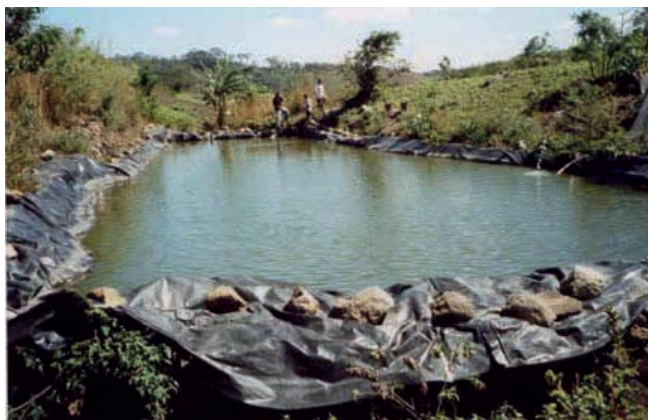
Figura 4. Estanque de tierra con revestimiento de membrana (Tomada de Saavedra, 2006)
