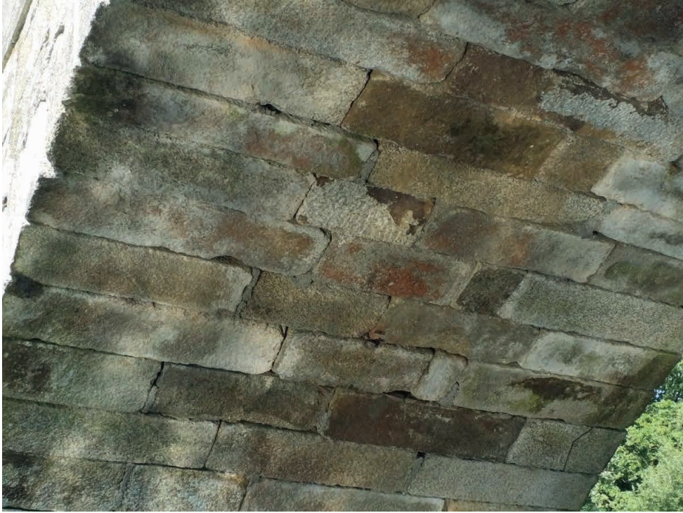
Figura 8: Vista general del alzado aguas abajo del Puente de Brandomil, en imagen captada con el drone multi rotor empleado en la inspección de este artículo (fotografía del autor).
