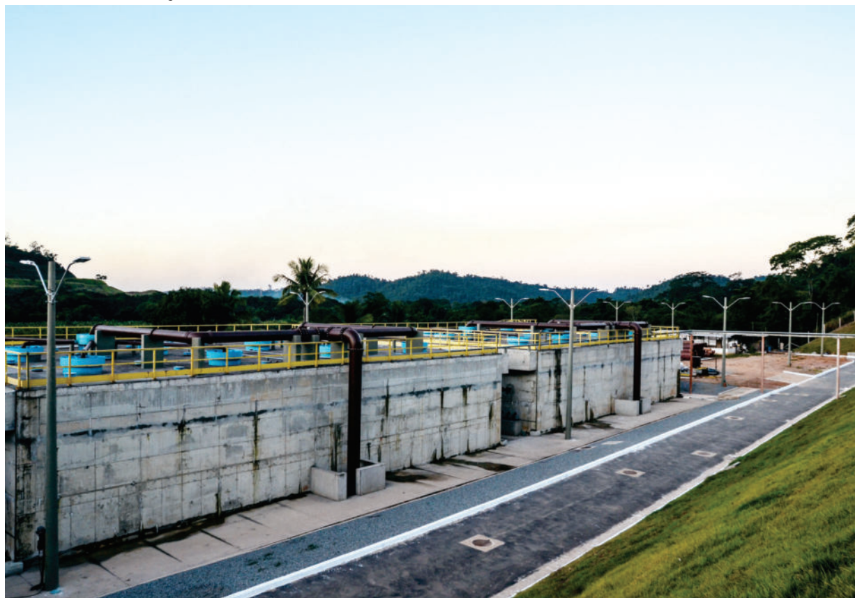
Figura 9.3 - Estação de tratamento de Esgoto de Timóteo e Coronel Fabriciano.
