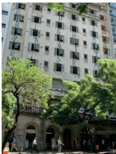
Figura 4: Edifício público desocupado (2008)
