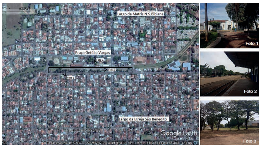
Figura 12 – Área vazia da Esplanada de Martinópolis. Fonte: elaborado pela autora a partir da imagem do Google Earth, 2018 e fotos da autora, 2017.
