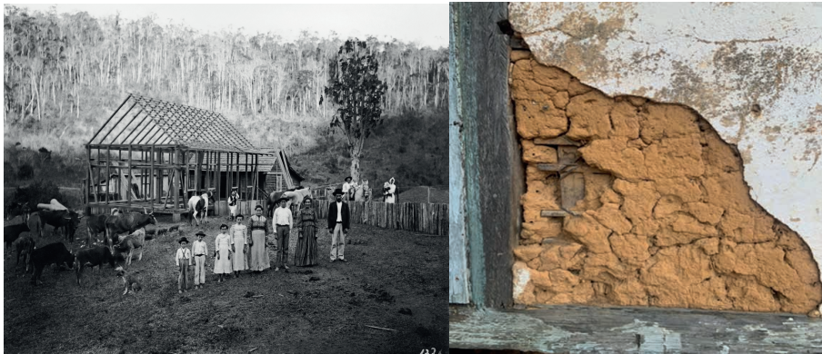
Figura 05- A esquerda construção de casa Enxaimel por imigrantes; A direita, parede de Taipa de mão.
