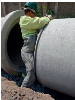
Figura 7 – Instalação da junta elástica.
