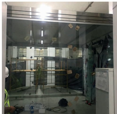
Figura 20 – Instalação das esquadrias de alumínio
