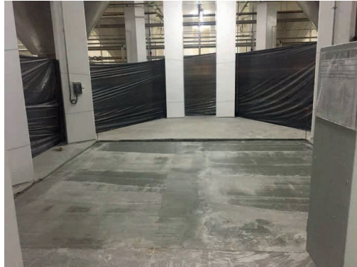
Figura 18 – Nivelamento e preparação do contrapiso para instalação do módulo em estudo
