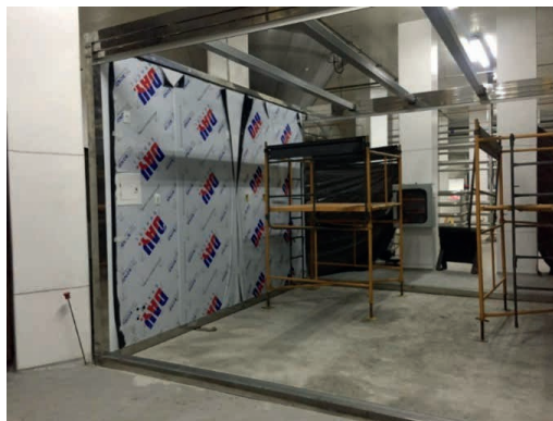
Figura 19 – Montagem do módulo em andamento
