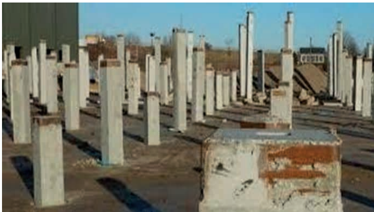
Figura 12: Estacas pré-moldadas de concreto
