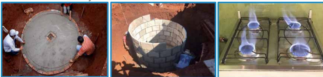
FOTO 12 – CONSTRUÇÃO DE BIODIGESTOR – SR. NELSON
