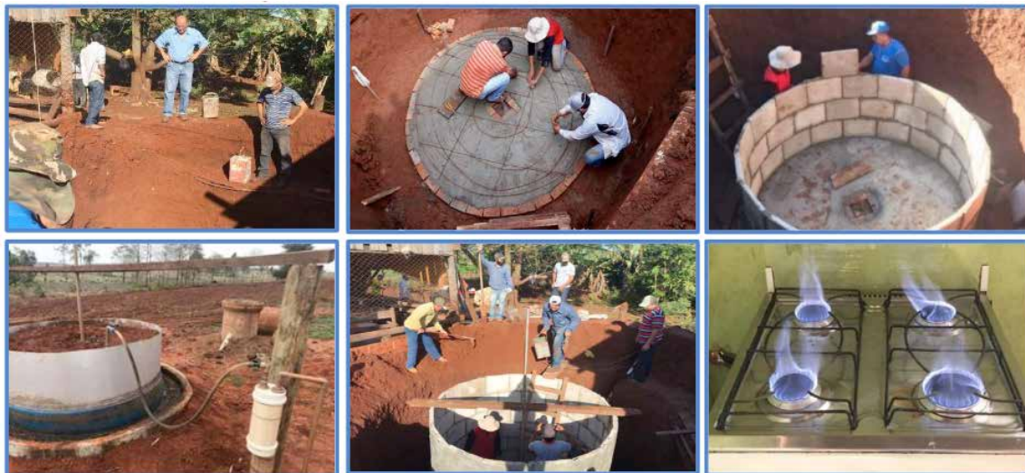
FOTO 1 - CONSTRUÇÃO DE BIODIGESTOR – Assentamento Itamarati – Sr Nelson 13
