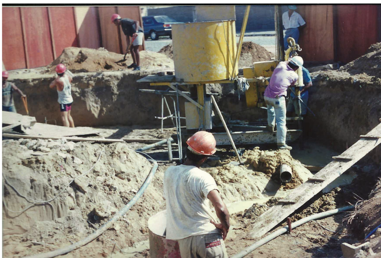
Figura 8-Construção da fundação da torre de concreto da ERB Ponta Negra
