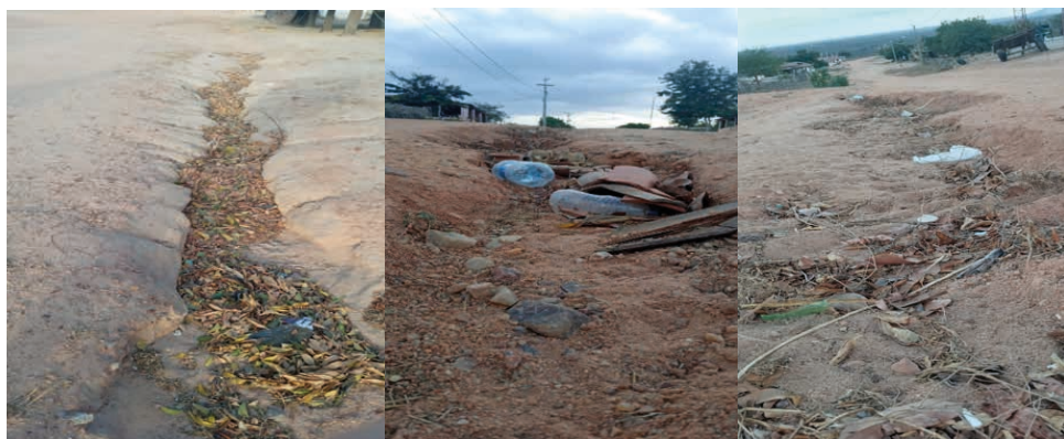
Figura 04: Lixo nos buracos
