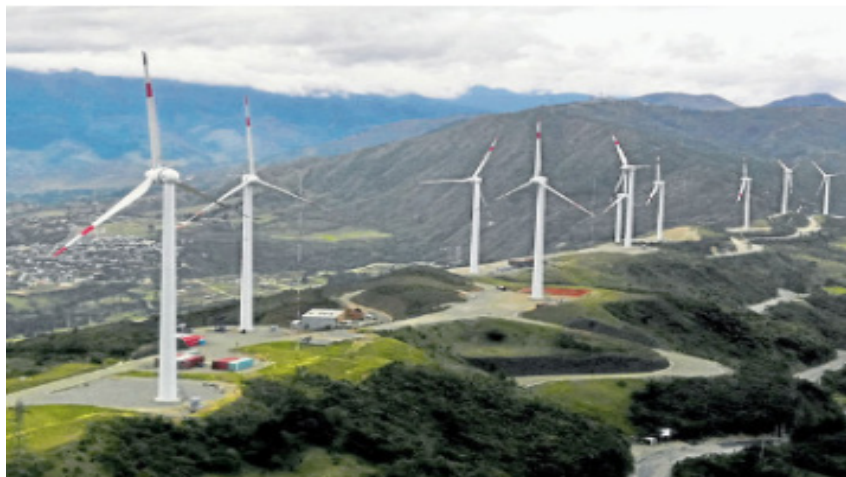
Figura 18. Central Eólica en Villonaco, Loja, Ecuador.
