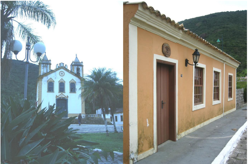
Figura 5 - Freguesia do Ribeirão da Ilha: Igreja Nossa Senhora da Lapa e a fachada de uma das casas que compõem o conjunto histórico desta localidade.
