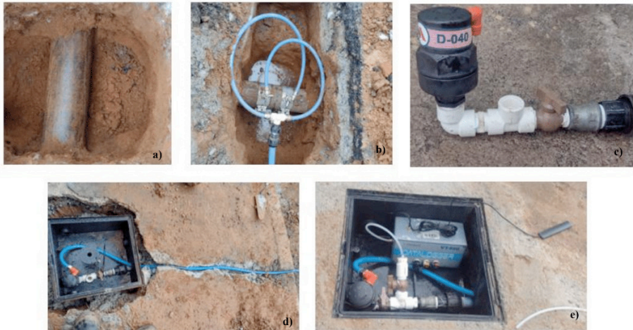
Figura 05 – Instalação caixa no passeio.
