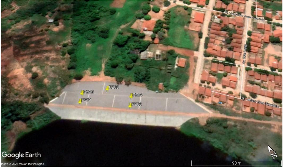
Figura 3 – Os cinco piezômetros instalados na barragem principal.
