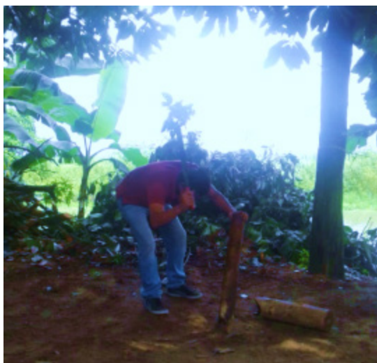
Foto 10. Elaboración de las estructuras.
