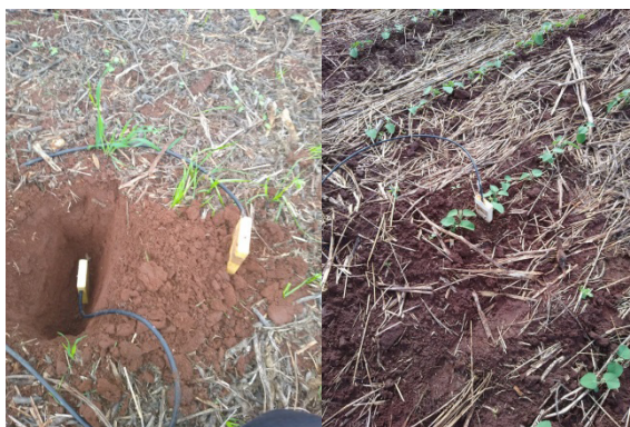
Figura 2. Instalação dos Sensores FDR a 0-30 cm e a 30-60 cm no perfil do solo. Cachoeira do Sul, RS.
