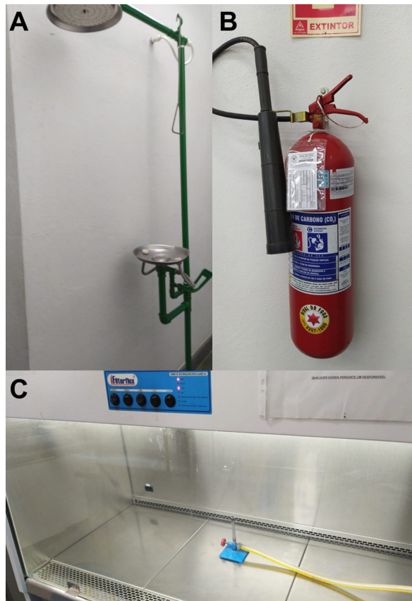
Figura 2 – Equipamentos de Proteção Coletiva. A: Chuveiro Lava olhos, B: Extintor de incêndio. C: Cabine de segurança biológica.
