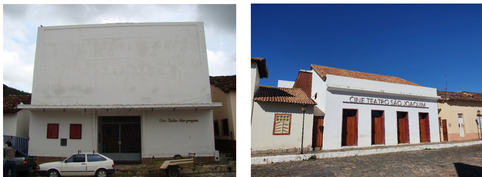
Figura 5 – Cine Teatro São Joaquim, à esquerda, em sua configuração antes das obras de requalificação e, à direita, após as mesmas, transformadas em reconstrução : gabarito mais elevado e substituição da tipologia moderna por outra que se assemelhe mais à feição histórica tradicional predominante na cidade.
